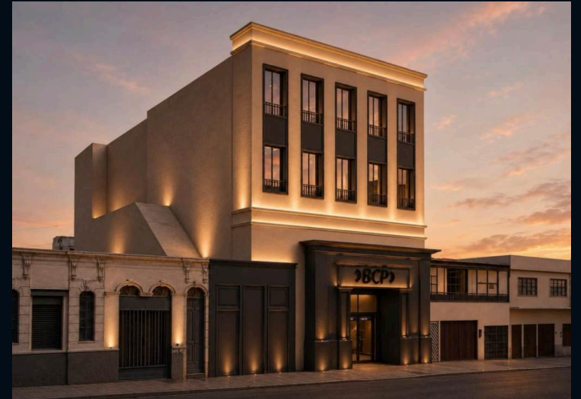
BCP – sede Moquegua
